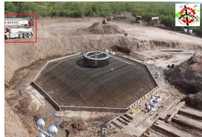
El impacto de las enormes cimentaciones (412 m 2 / 25 m. de diámetro) de estos gigantes de 200 metros provocan la deforestación de amplias zonas de alto valor medioambiental.
